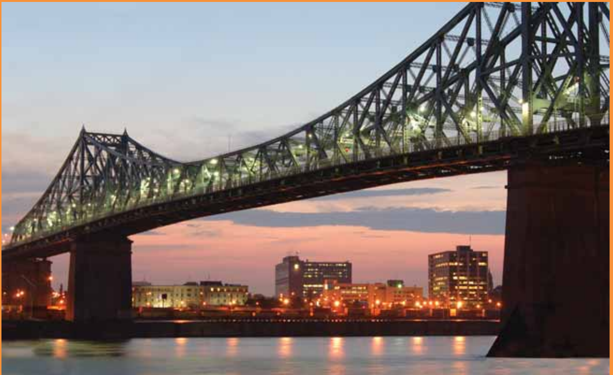
➤ Réfection du pont Jacques-Cartier Montréal, Québec
