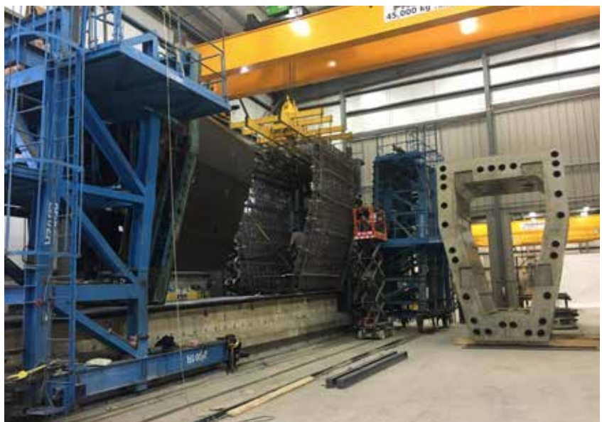
PRÉPARATION D'UNE COULÉE DE SEGMENTS DE PILIERS (MOULE ET ARMATURE)
