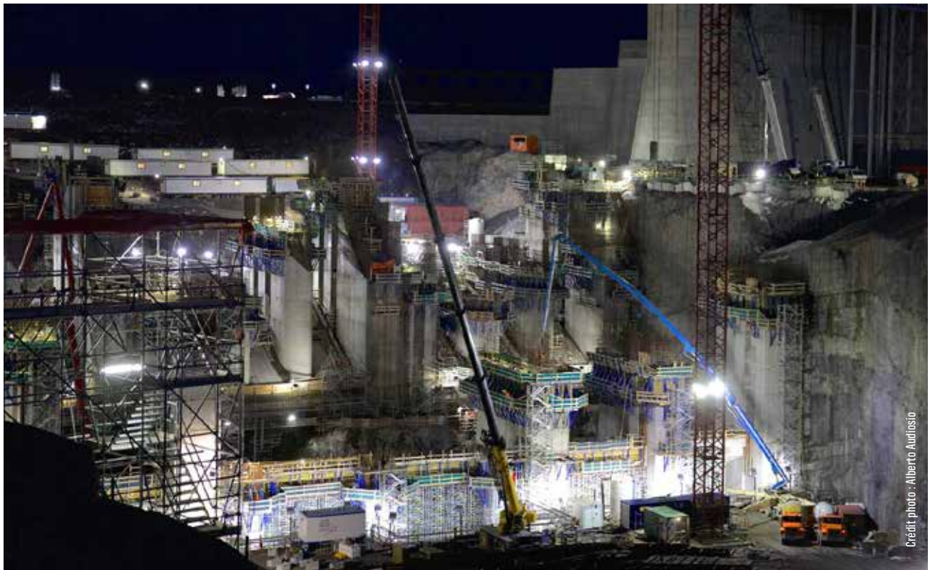
BÉTONNAGE DE NUIT
