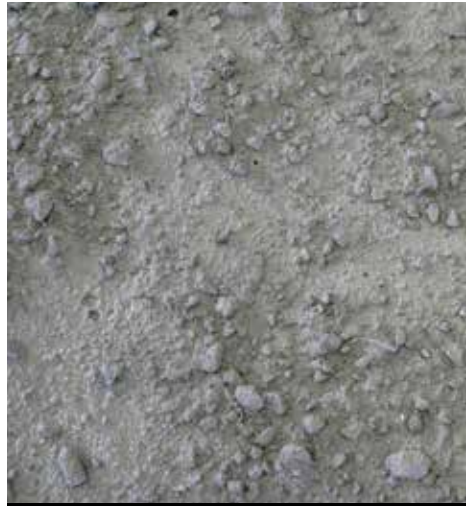
2 Béton à la mise en place
