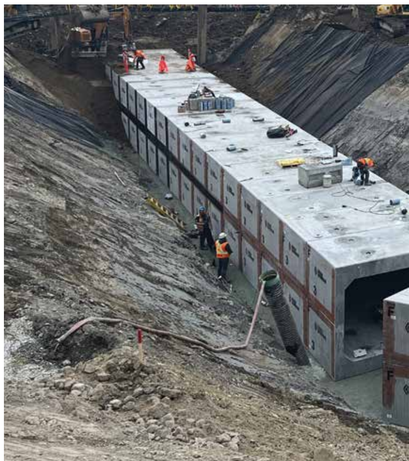
Construction de l'échangeur Darche à Sherbrooke
