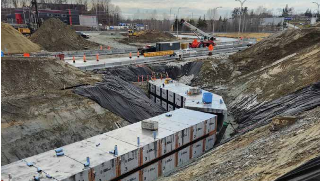
Construction de l'échangeur Darche, Sherbrooke
